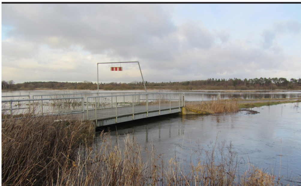
Eksempel på oversvømmelser ved Storåen i Herning Kommune. Foto: Orbicon.
