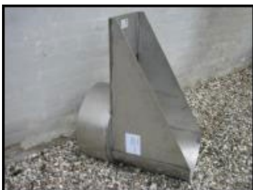
Figur 5.1 Enkeltblænde som fast regulering
